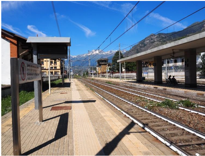
Fig. 2.4-iii Piazzale dei binari della stazione di Bussoleno: lato Sud Fonte: Sopralluogo META
