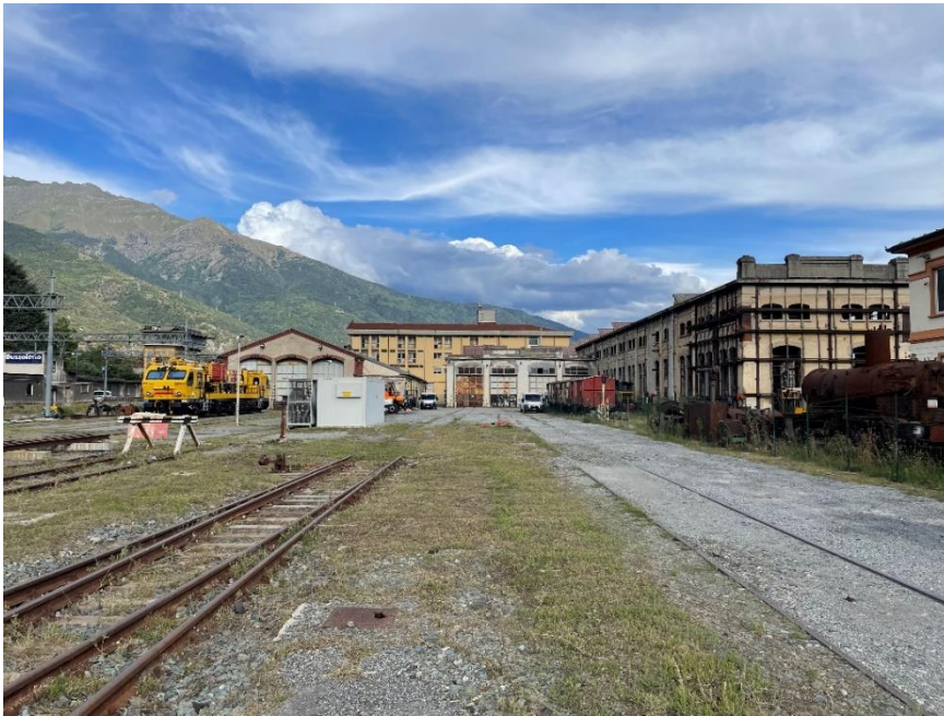
Fig. 4.5-iv – Impianti ferroviari prevalentemente dismessi della stazione di Bussoleno Rilievo diretto META
