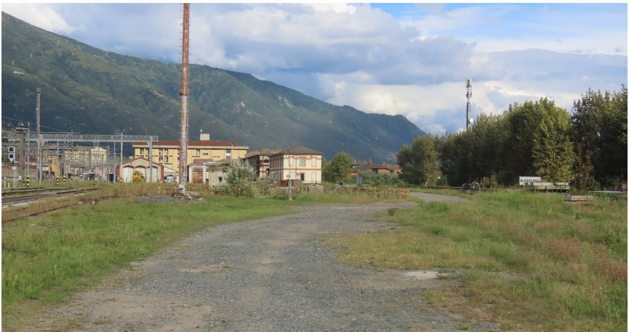
Fig. 4.5-v – Area di proprietà di RFI adiacente la SS 25 Rilievo diretto META
