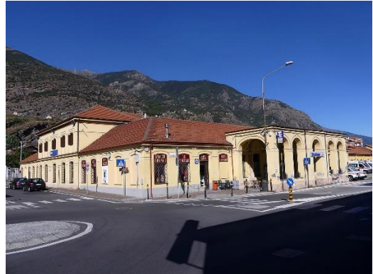
Fig. 2.4-vii - Stazione Ferroviaria di Susa
